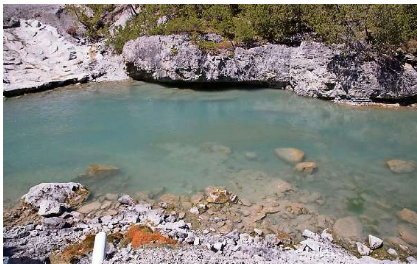
Zu reinigendes Tosbecken unterhalb der Stauanlage Punt dal Gall.
